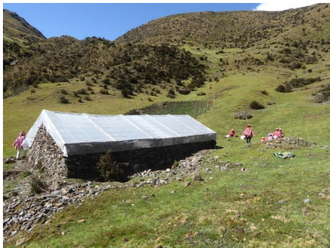
Aussenansicht eines durch uns gebauten Gewächshauses. Die UV-beständige Dachfolie hat eine Lebensdauer von etwa 7 Jahren.
