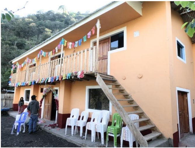
Aussenansicht des doppelstöckigen Gemeinschaftshauses.
