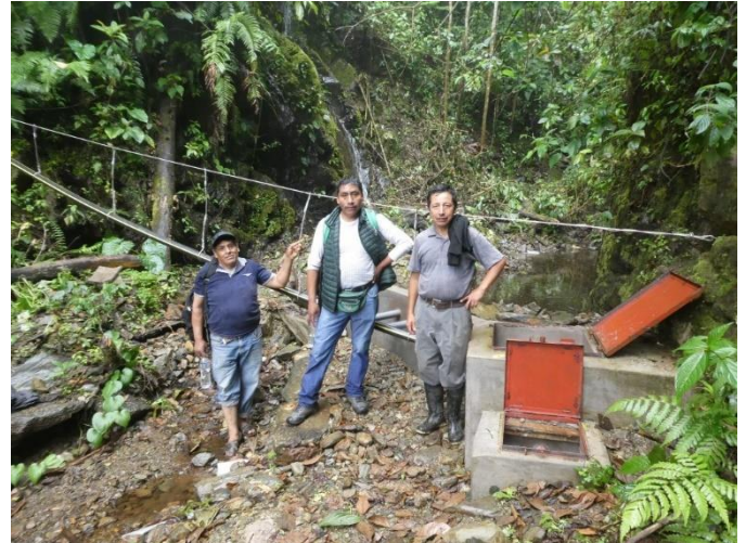
Wasserkammer. Von dort fließt das Wasser etwa 3 km weit über Schläuche und Rohre zu den Agrarflächen.
