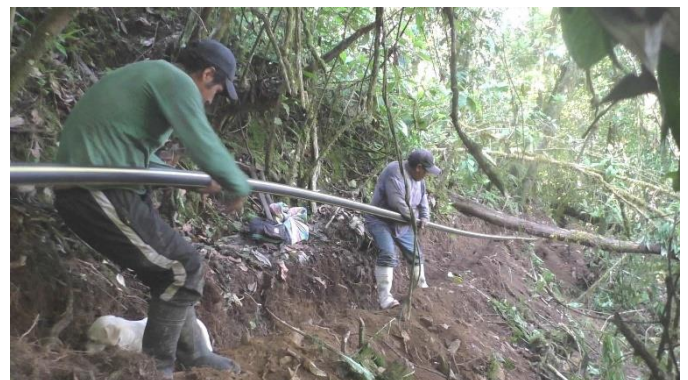
Die 3 km langen Wasserschläuche wurden in 30 cm Tiefe in schwierigem Terrain vergraben.
