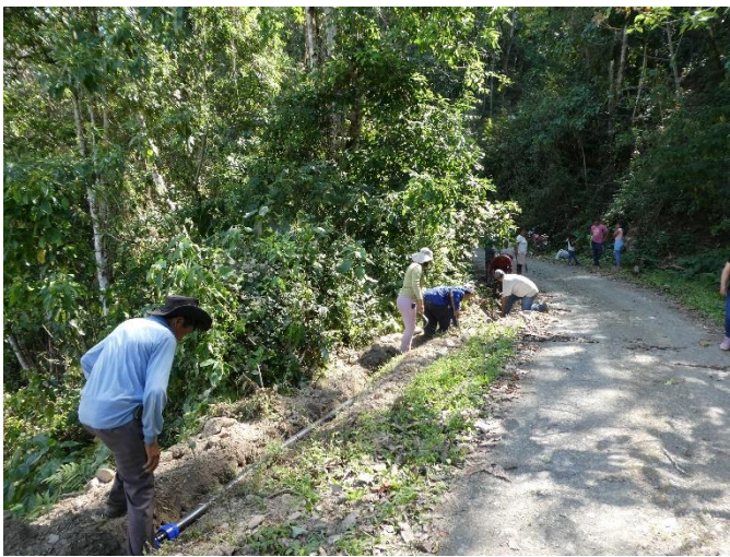
Las tuberías de agua se enterraron para protegerlas de posibles daños.
