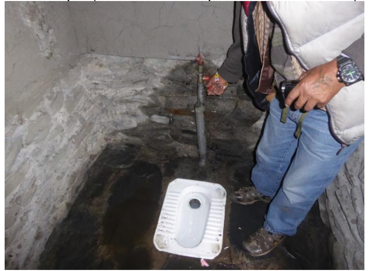
Conexión de agua desde dentro, equipada con un caño simple (aún no está completamente terminada).
