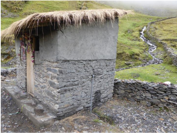
Conexión de agua visto de fuera.
