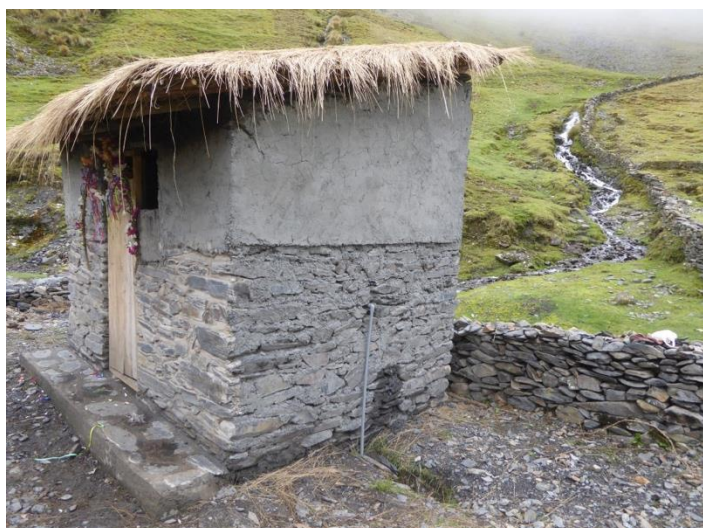
Vue extérieure du raccordement à l'eau.
