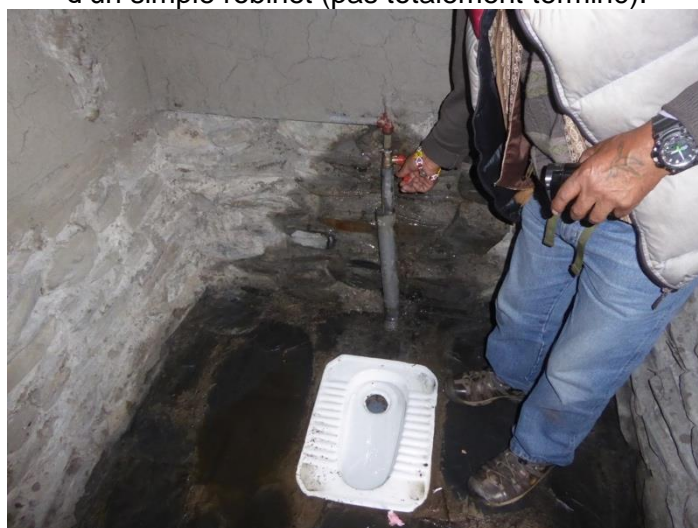
Vue intérieure du raccordement à l'eau, par le biais d'un simple robinet (pas totalement terminé).
