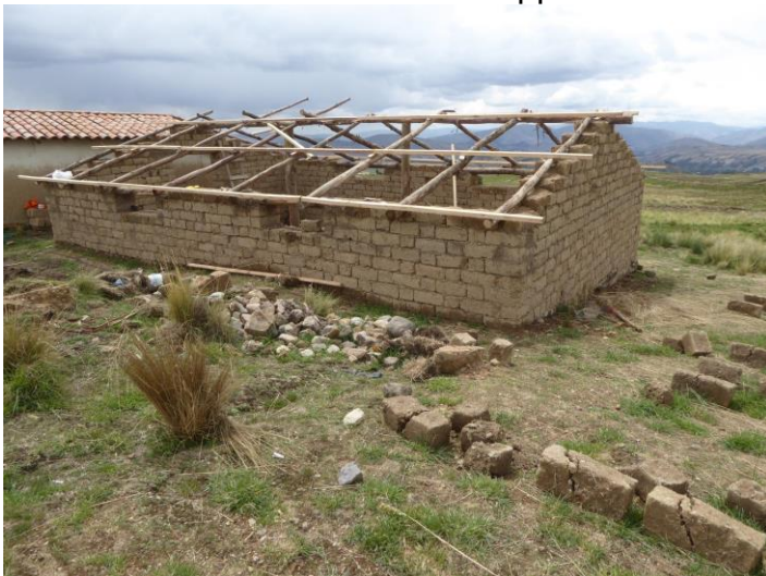
Beginn des Baues des ersten Meerschweinenschuppens
