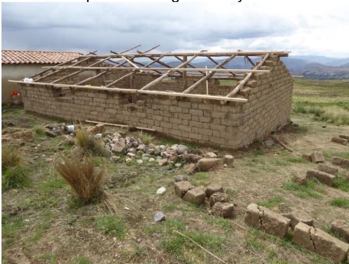
Début de la construction du premier hangar de cuyes.
